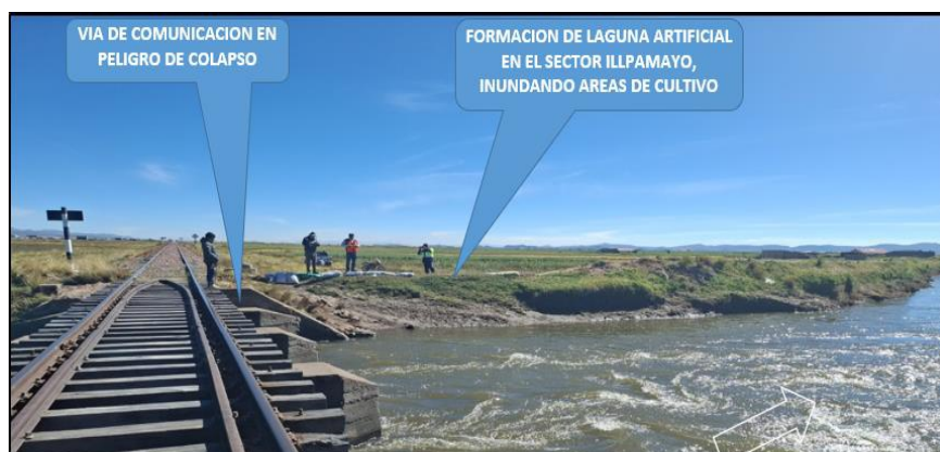
FIGURA 1 y 2 : TRAMO CRÍTICO EN EL RÍO ILLPA, EN EL SECTOR ILLPAMAYO, DISTRITO DE PAUCARCOLLA, PROVINCIA DE PUNO - PUNO. NOTESE, LA MARGEN AMBAS MARGENES DEL RIO ILLPA QUE REQUIERE LA CONFORMACION DEL DIQUE FUSIBLE PARA EVITAR EL DESBORDE E INUNDACIONES.
